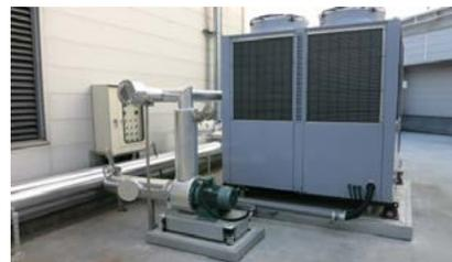
氣冷式冰水機與冰水泵
