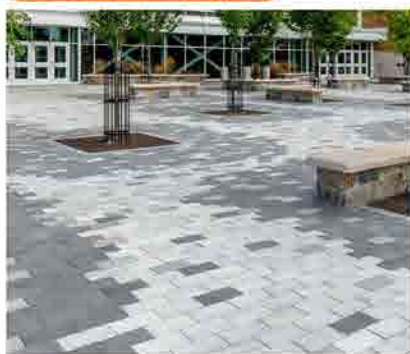
高壓透水連鎖磚鋪面
