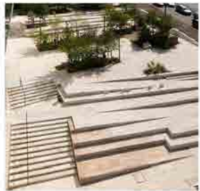
無障礙斜坡座階
