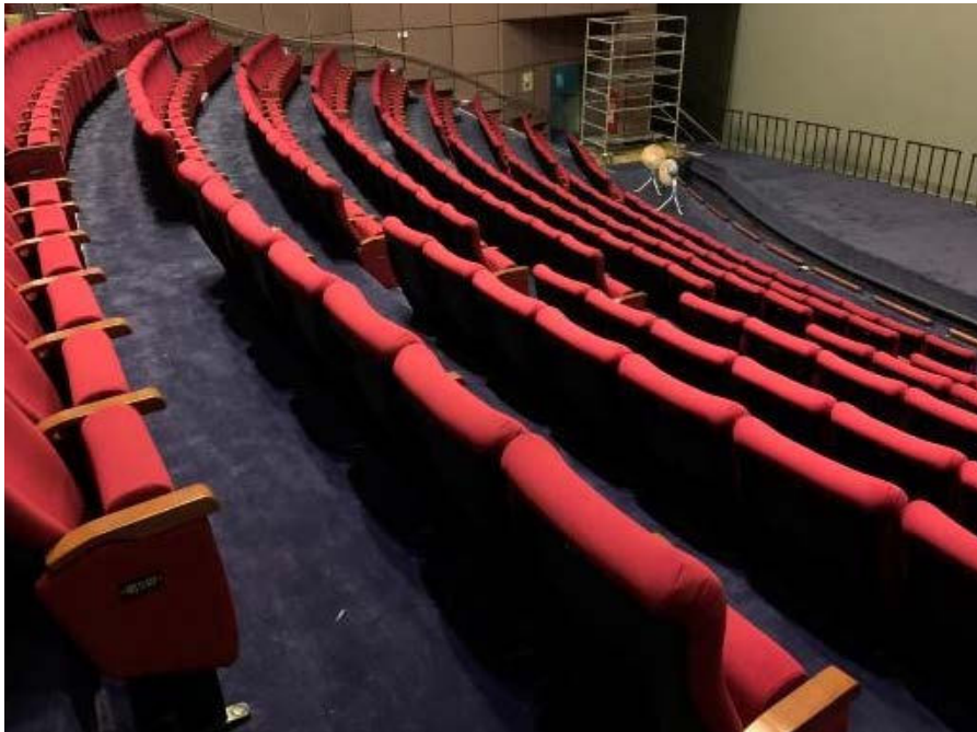
大銀幕電影院翻修，以提高場域使用率及彈性度。
