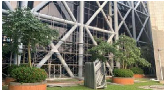
展示大樓戶外鋼構美化工程
