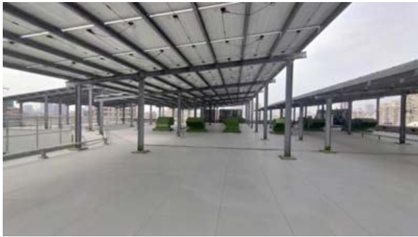
屋頂防水隔熱改善工程
