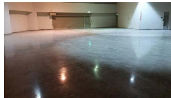
第一特展廳已完成環境更新工程
