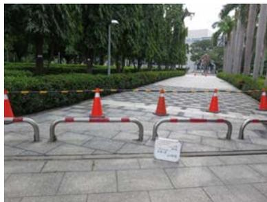
庚、戶外舊有地坪填縫處理：舊有填縫經雨水沖刷而流失，易使大理石地坪鬆動，故重新處理填縫，藉以固定大理石。
