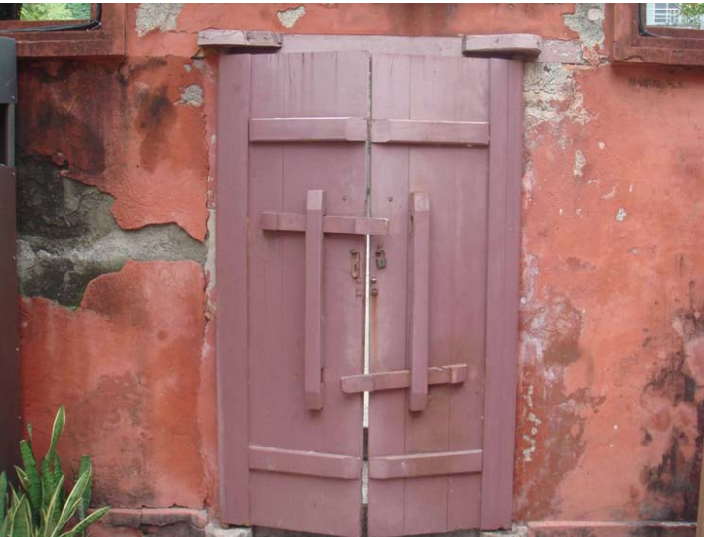
古中國門鎖僅由做為障礙物的厚重門門和做為固定裝置的門板兩部分所構成，用以防止門窗的開啓。
